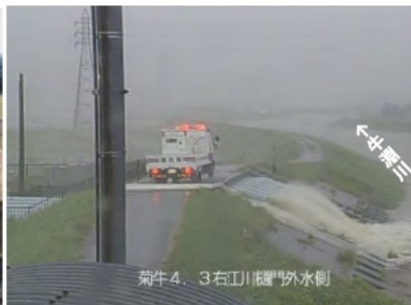
排水ポンプ稼働状況
