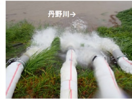
排水ポンプ稼働状況
