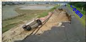
【裏法崩れ】L=約80m 小田川左岸4k200付近
