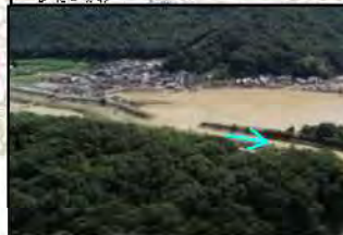
【堤防の決壊】L=約100m 真谷川左岸1k600付近(県)
