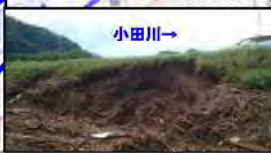
【裏法崩れ】L=約15m 小田川右岸4k200付近
