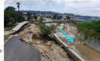
【堤防の決壊】左岸L=約200m 右岸L=約300m 末政川左右岸0k700付近(県)
