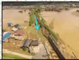
【堤防の決壊】 左岸L=約20m(高馬川左岸0k付近) 右岸L=約100m(高馬川右岸0k100付近)
