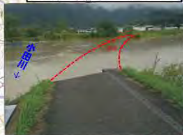
【堤防の決壊】L=約50m 小田川左岸6k400付近
