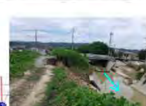
【堤防の決壊】L=約20m 末政川左岸0k400付近(県)
