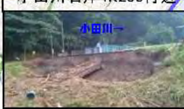
【裏法崩れ】L=約16m 小田川右岸4k200付近
