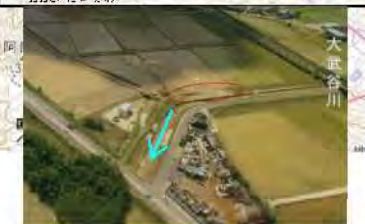
【裏法崩れ】L=約50m 大武谷川(県)小田川合流点付近
