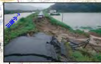
【裏法崩れ】L=約30m 小田川右岸0k600付近
