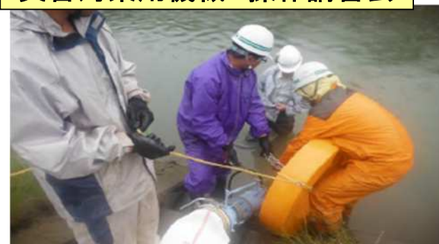
排水ポンプ車の設置・排水訓練
