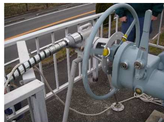
開閉装置と樋門の接続
