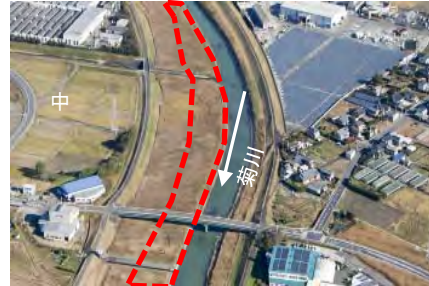
■ ③ 流下能力対策(掘削)
