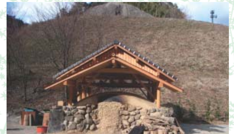
雨よけの屋根をつくって完成！
