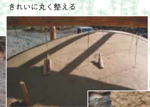
土をかぶせて窯の天井をつくる
