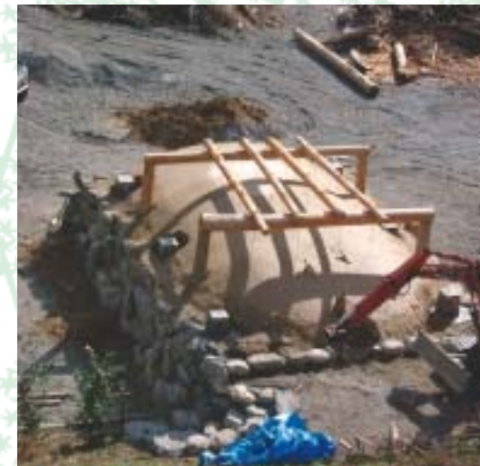
土をかぶせて窯の天井をつくる
