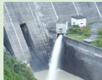
利水放流設備
