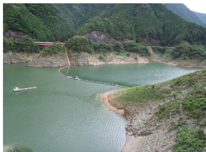
(流入水制御フェンス)
