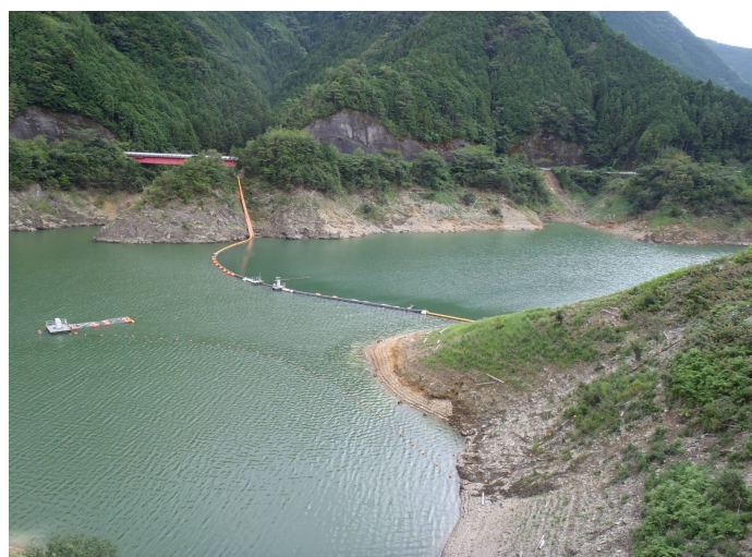
(流入水制御フェンス)
