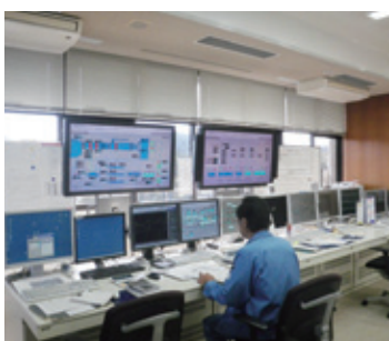
南勢水道 操作室
