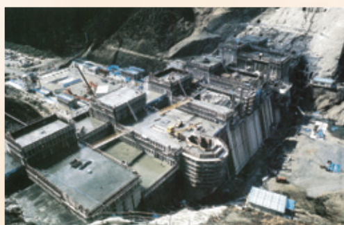
コンクリート打設状況
