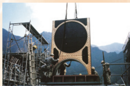
副放流設備・修理用ゲート扉体吊込み
