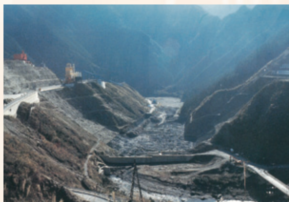
本体掘削完了
