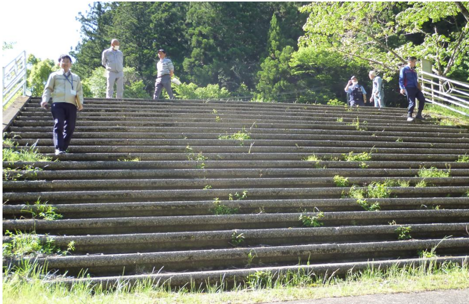
ダム湖周辺の点検
