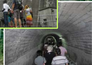
ダムの堤体内を探検するよ
