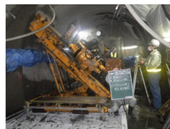
集水ボーリング工
