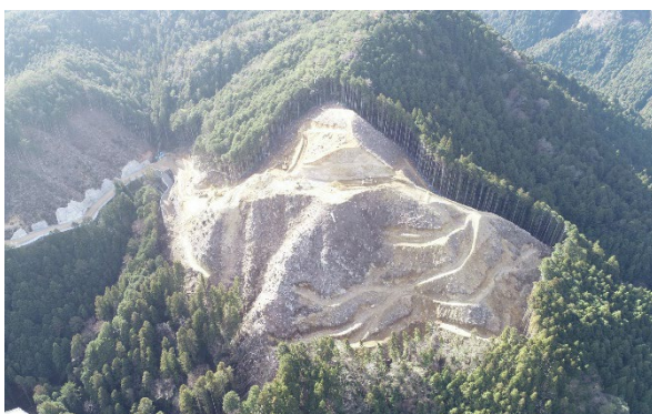
本体工事(基礎掘削)
