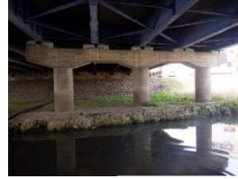
【対策事例】橋梁の耐震補強
