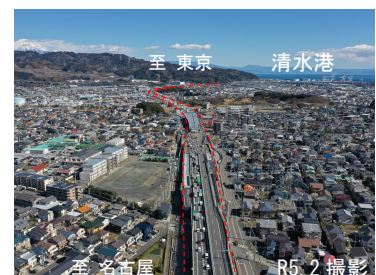
R8年春頃開通に向け工事が進む 静清バイパス（清水立体）
