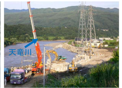
平成18年7月豪雨応急復旧状況
