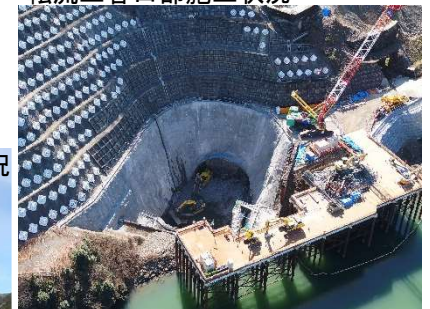
転流工呑口部施工状況
