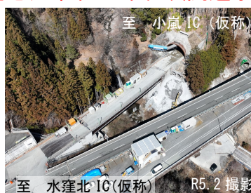
三遠南信自動車道 青崩峠道路 静岡側坑口
