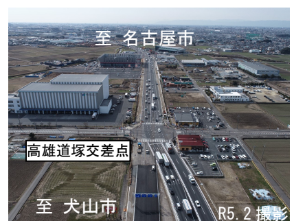
至 名古屋市 高雄道塚交差点 至 犬山市 R5.2 撮影 令和5年度開通に向け工事が進む 名濃バイパス 高雄道塚交差点付近
