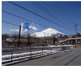
【整備事例】国道138号 須走電線共同溝
