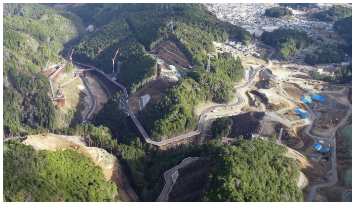
工事用道路(廃棄岩骨材運搬路等)
