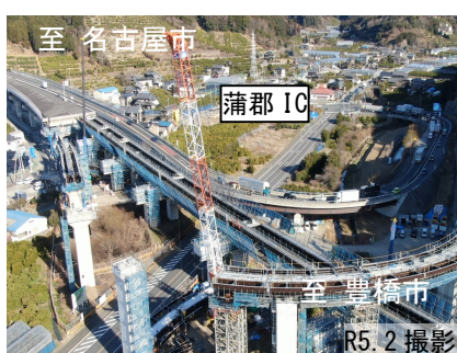
至 名古屋市 蒲郡 IC 至 豊橋市 R5.2 撮影 令和6年度開通に向け工事が進む 蒲郡バイパス 蒲郡IC付近
