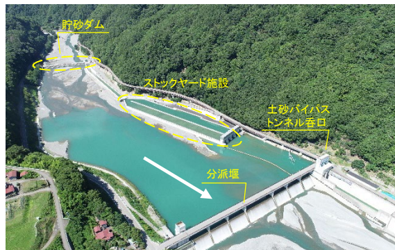
分派堰上流 貯水池堆砂対策施設
