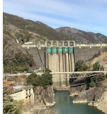
新丸山ダム本体付近施工状況
