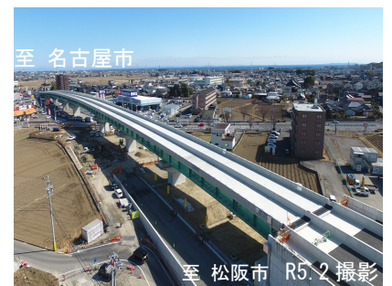
令和5年度開通に向け工事が進む 中勢道路 北玉垣高架橋付近
