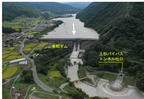
美和ダムと土砂バイパストンネル
