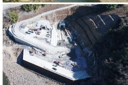
転流工吐口部施工状況
