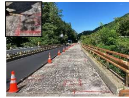
【対策事例】床版上面の断面補修
