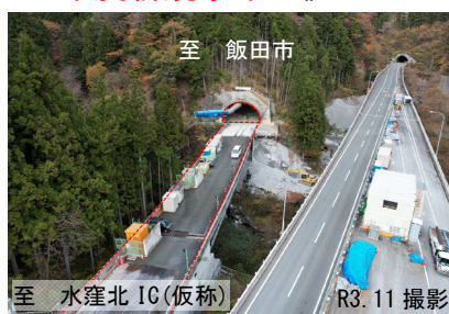
トンネル工事状況(静岡側) 青崩峠道路
