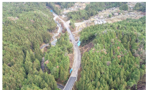
付替県道設楽根羽線(1号橋~1号トンネル)
