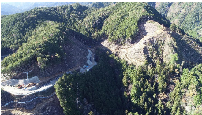
本体工事(基礎掘削)
