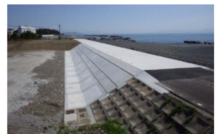
粘り強い構造の海岸堤防(焼津市)
