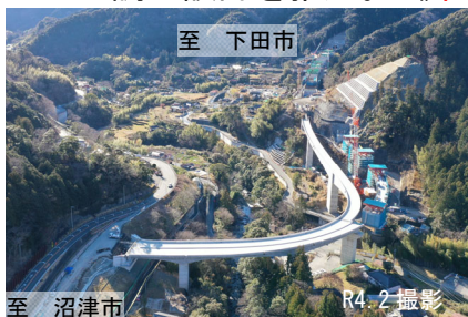
令和4年度一部開通に向け工事が進む 河津下田道路(Ⅱ期) 河津IC(仮称)付近
