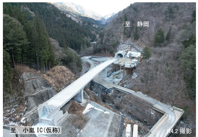
トンネル坑口付近の工事状況 あおくずれとうげ 青崩峠道路（長野側）
