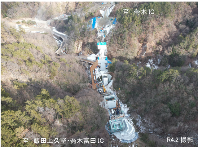
橋梁下部工の施工状況 いいたか 飯嵩道路
