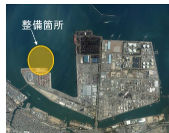
四日市港霞ヶ浦地区 国際物流ターミナル整備事業
