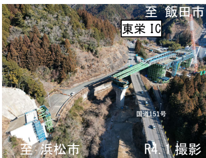
令和7年度開通に向け工事が進む 佐久間道路・三遠道路 東栄IC付近
