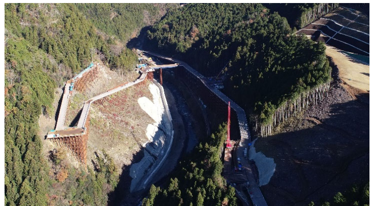
工事用道路(廃棄岩骨材運搬路等)
