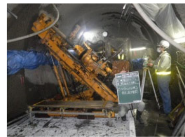
集水ボーリング工
