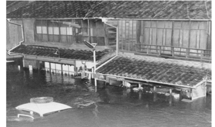
写真1:軒下まで浸水した家屋
