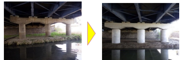
【対策事例】橋梁の耐震補強
