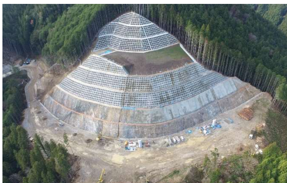
本体工事(基礎掘削)
