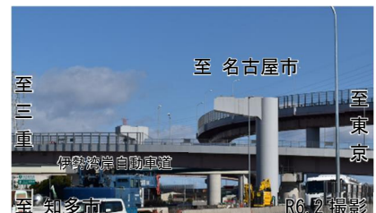
西知多道路 東海ジャンクション
