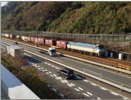
重要交通網(国道1号、JR東海道本線(旅客、貨物))
