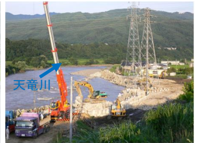
平成18年7月豪雨応急復旧状況
