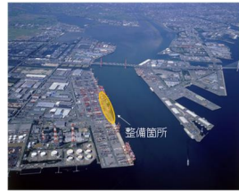
名古屋港飛島ふ頭再編整備事業 (飛島ふ頭地区)
