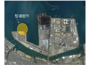
四日市港霞ヶ浦地区 国際物流ターミナル整備事業
