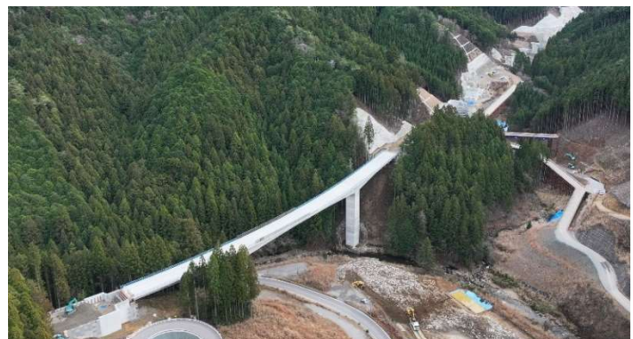
付替県道設楽根羽線(5号橋)
