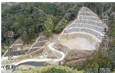
伊豆縦貫自動車道 河津下田道路(Ⅱ期) 下田北IC(仮称)付近
