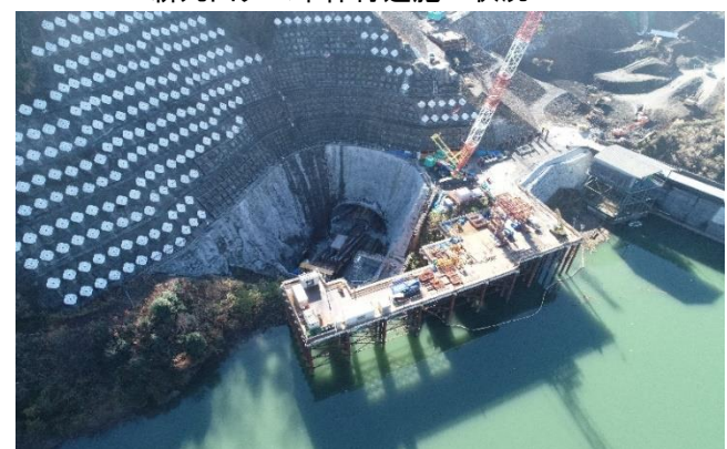
転流工呑口部施工状況
