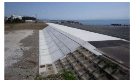
粘り強い構造の海岸堤防(焼津市)
