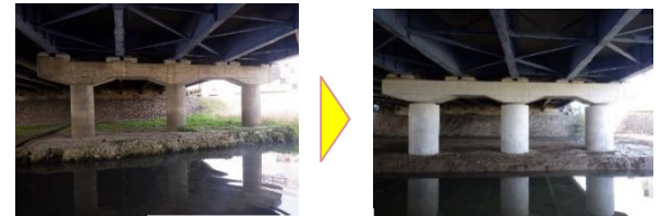
【対策事例】橋梁の耐震補強
