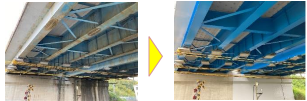
【対策事例】橋梁の再塗装
