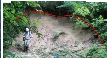
崩壊地の状況
