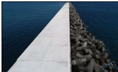
沈下対策 (上部工嵩上げ)
