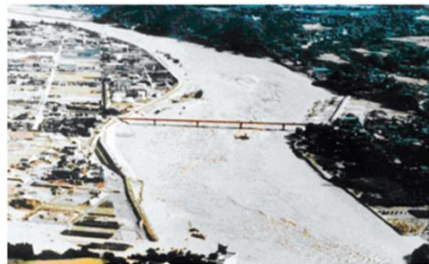
S58年台風10号災害浸水状況(飯田市松尾地区)
