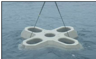
基礎の流出防止対策 (被覆ブロック据付)
