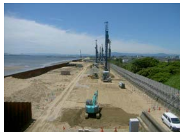
津松阪港海岸保全施設整備事業
