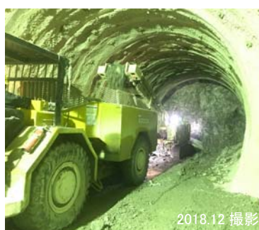
トンネル調査坑工事の状況 青崩峠道路
