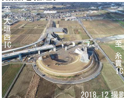
2019年度開通に向け工事が進む 東海環状自動車道 大野・神戸IC
