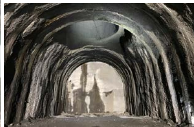
転流工施工状況 (トンネル坑内 貫通点)
