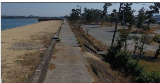
整備前の堤防(阿漕浦・御殿場工区)
