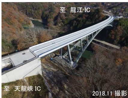
2019年度開通に向けた工事の状況 飯喬道路 天龍峡大橋
