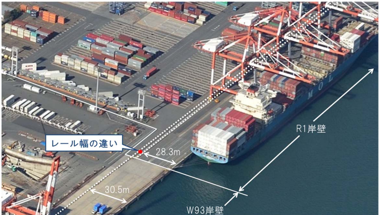
ガントリークレーンのレール幅の違い
