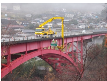
橋梁の点検状況
