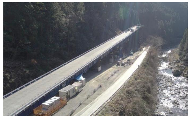
工事用道路（廃棄岩骨材運搬路）
