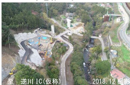
至 逆川 IC（仮称） 2018.12 撮影 橋梁工事等が進む 伊豆縦貫自動車道 河津下田道路（Ⅱ期） 河津IC（仮称）付近
