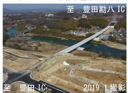
2019年度開通に向けて工事が進む 豊田北バイパス 平戸大橋付近
