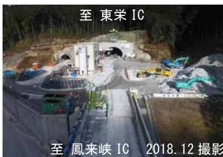
トンネル工事の状況 佐久間道路・三遠道路 三遠第3トンネル
