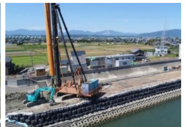
木曾川津波対策耐震事業
