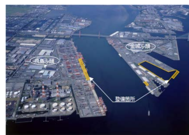
名古屋港 岸壁整備箇所
