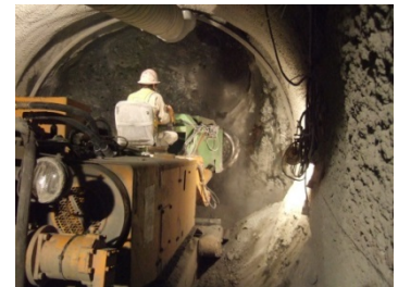
排水トンネル工
