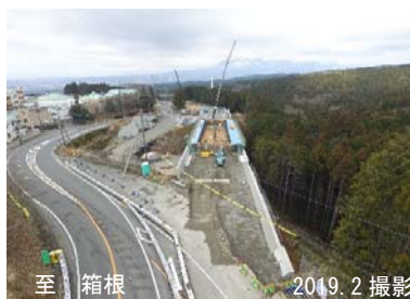
至 箱根 2019.2 撮影 2019年度開通に向け工事が進む 笹原山中バイパス 2号橋付近
