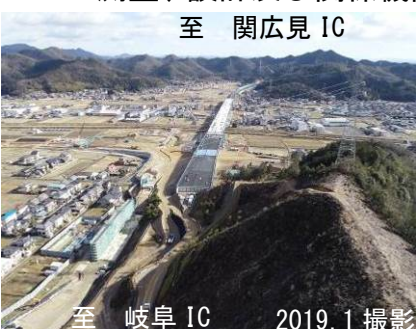
2019年度開通に向け工事が進む 東海環状自動車道 高富IC付近
