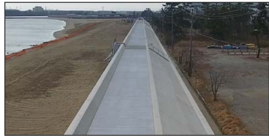
整備後の堤防(阿漕浦・御殿場工区)
