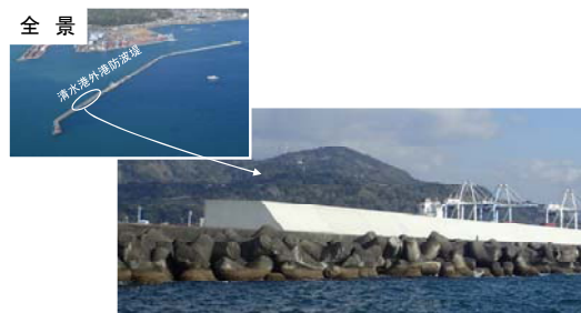
緊急対策のイメージ(防波堤の補強)
