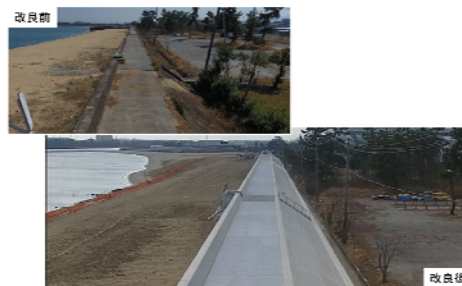
緊急対策のイメージ(堤防改良)
