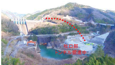
転流工施工状況
