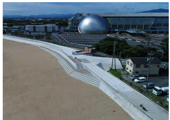
整備後の堤防(阿漕浦・御殿場工区)
