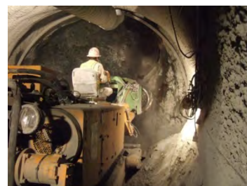
排水トンネル工
