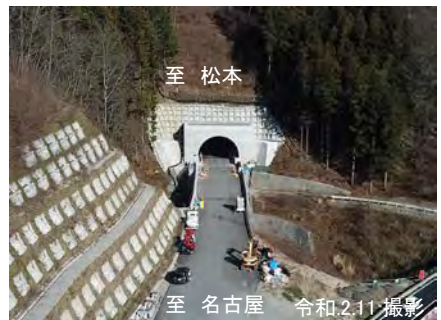
令和3年秋頃開通に向けた 工事の状況 桜沢改良
