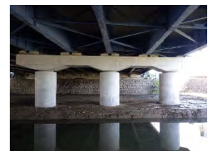
【対策事例】橋梁の耐震補強
