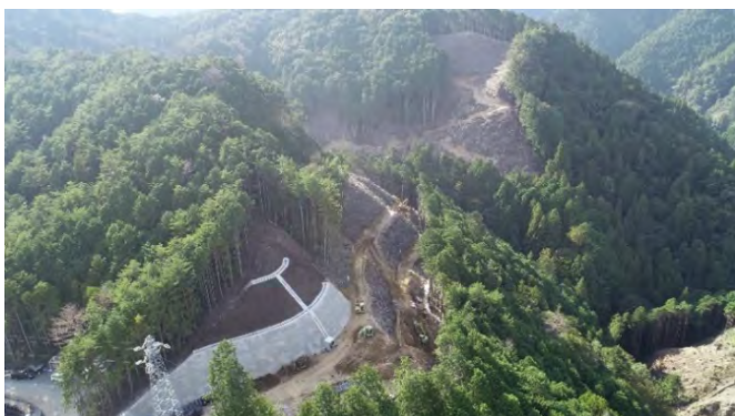
本体工事(基礎掘削)
