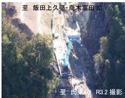
橋梁下部工の施工状況 飯橋道路
