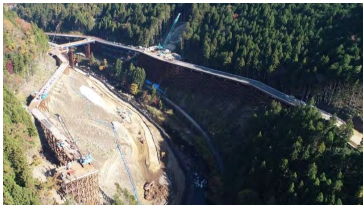
工事用道路(廃棄岩骨材運搬路等)
