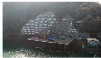
転流工呑口部施工状況
