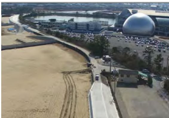
整備前の堤防(阿漕浦・御殿場工区)
