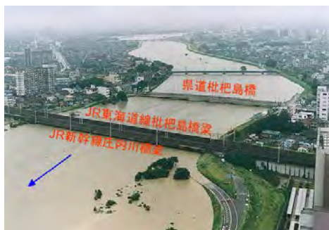
橋梁の橋げた付近まで水位が上昇(枇杷島地区)
