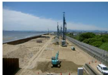
津松阪港海岸 直轄海岸保全施設整備事業
