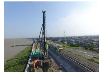
木曾川津波対策耐震事業
