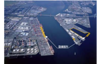
名古屋港ふ頭再編整備事業 (飛島ふ頭、金城ふ頭)
