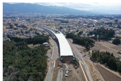
御殿場バイパス(西区間)
