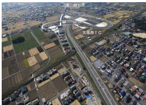
大垣西IC 付近 工事状況
