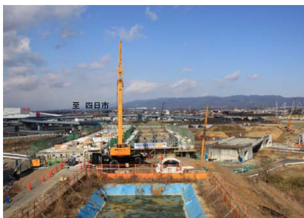
東員IC 付近 工事状況
