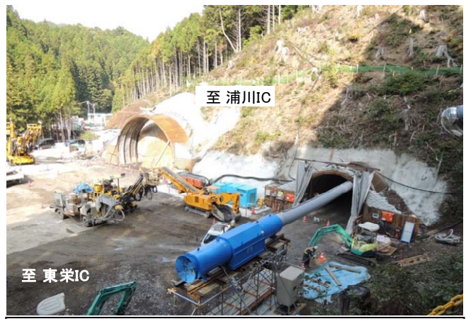
佐久間第一トンネル 東栄町側坑口付近 工事状況
