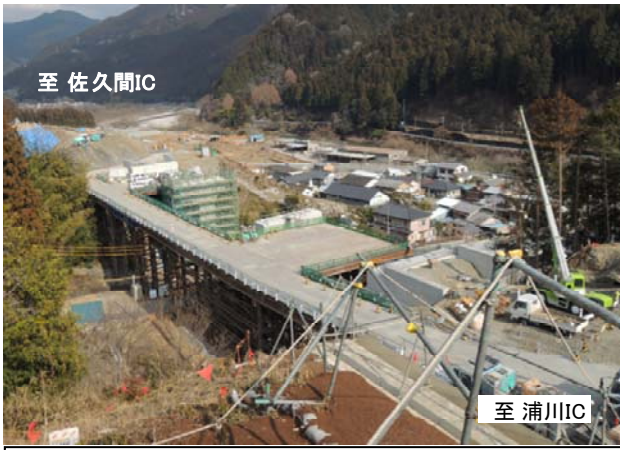
佐久間IC（仮称）付近 工事状況
