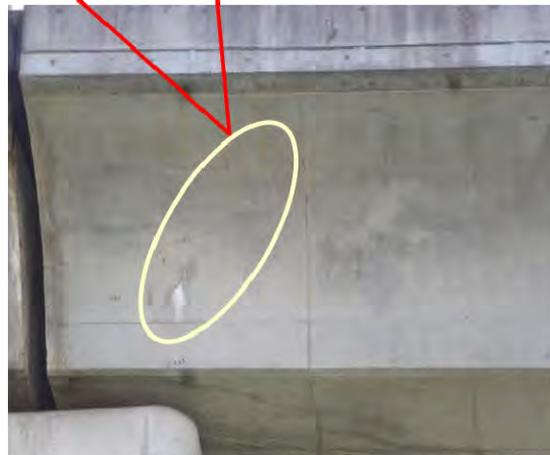
PC中空床版橋桁端部(ひびわれ及び遊離石灰)
