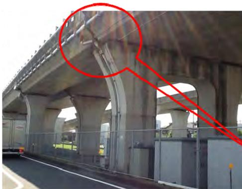
桁端部等のコンクリート充実部の初期ひびわれを抑制することが長期的な品質の保証へ繋がる。
