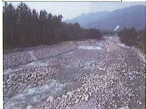
床固工群の状況 (H21年度施工)
