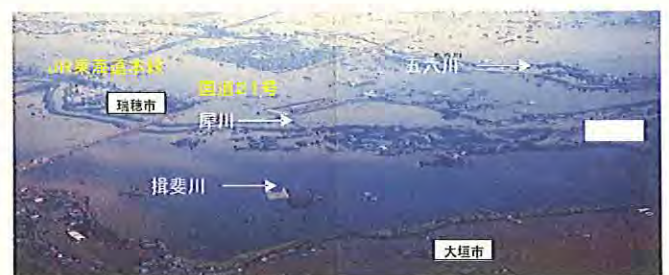
昭和51年9月洪水の被害状況
