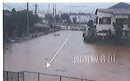
平成10年8月洪水の浸水状況
