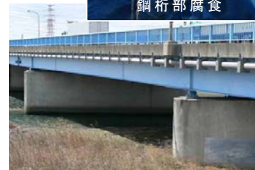
国道 23 号 町屋大橋 （三重県桑名市）
