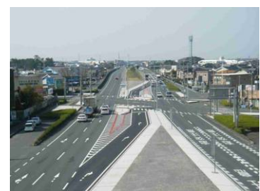
整備事例：国道1号 浜松市南区芳川交差点 ほうがわ
