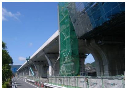
国道 1 号静清バイパス 昭府高架橋の状況
