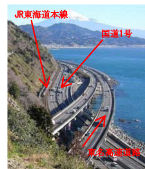
地すべりと併走する重要交通施設
