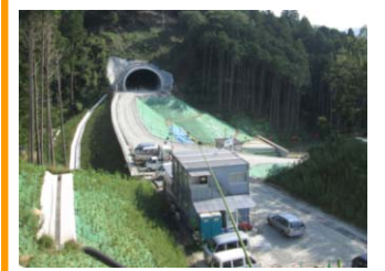
あまぎた 伊豆縦貫自動車道 天城北道路 ひなた 日向トンネル(仮称)工事状況
