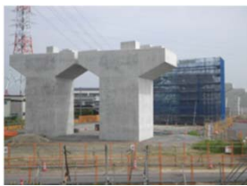
おおがき (岐阜県内) 大垣地区橋梁工事状況
