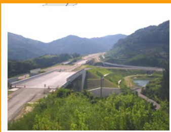
がまごおり 名豊道路 蒲郡バイパス 蒲郡西IC(仮称)改良工事状況
