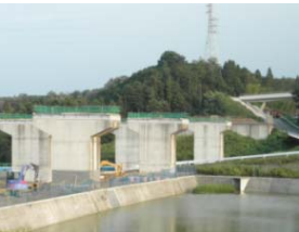
さらいん (三重県内) 東員地区橋梁工事状況
