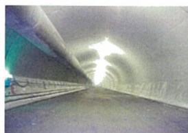
高丸山トンネル工事状況
