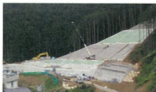
尾鷲北IC付近の工事状況
