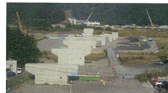
海山IC付近の工事状況
