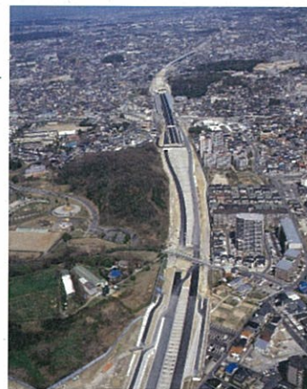
有松IC付近工事状況
