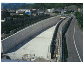
昭府地区工事状況
