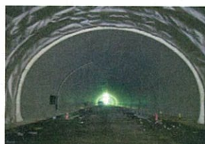
賤機山トンネル工事状況
