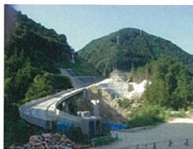
鳳来IC(仮称)付近工事状況
