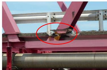
破断の状況(H19.6.20 破断発見)
