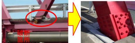
道路橋部材の破断の状況 (H19.6.20破断発見)
