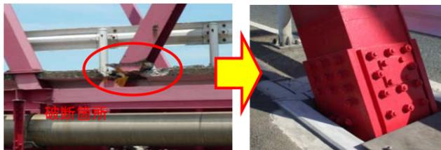
道路橋部材の破断の状況 (H19.6.20破断発見)
