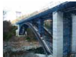
国道 19 号栈改良 (4 号橋)
