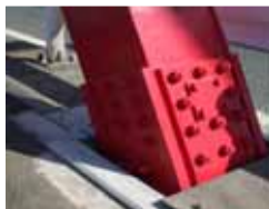
緊急対策実施(添設板)
