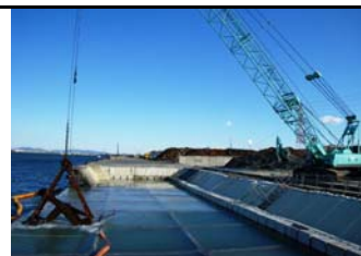
■岸壁の耐震改良施工状況
