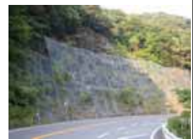
国道 42 号防災工事 熊野市大泊地区
