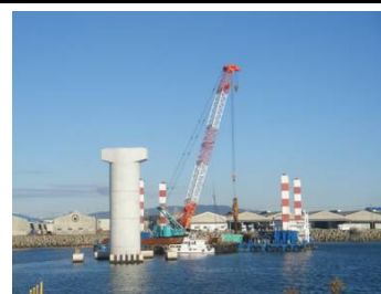
■橋梁下部工 施工状況
