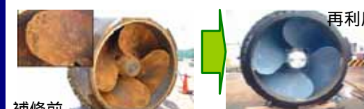
部品を再利用し排水機場を補修
