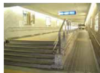
階段部にスロープを設置した事例 (静岡駅前地下横断歩道)
