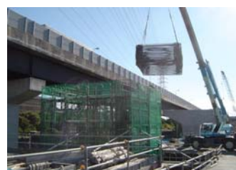
■臨港道路(武豊線)整備状況
