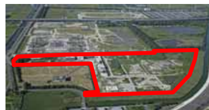
日光川下流浄化センター
