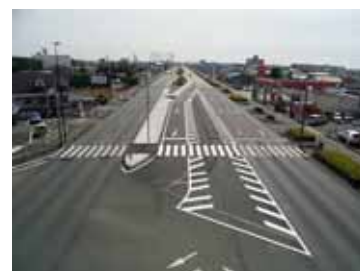
右折レーンの分離の事例 (国道 1 号浜松市飯田交差点)
