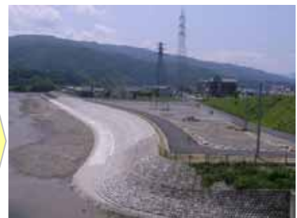
現在の現場状況
