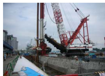
■背後鋼管杭 打設状況
