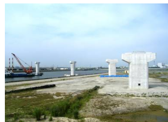
■霞ヶ浦北ふ頭地区 整備状況
