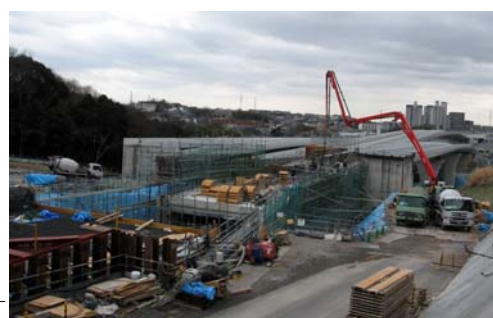
<有松高架橋(東南部区間)>
