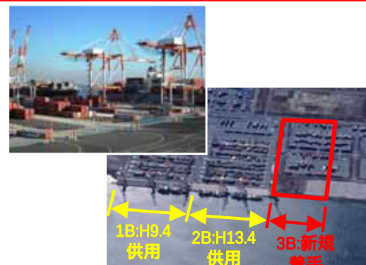
名古屋港鍋田ふ頭地区国際海上コンテナターミナル
