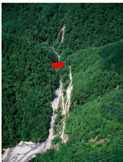
施工箇所写真
