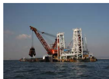
■航路泊地 浚渫状況
