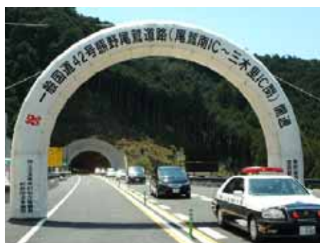
国道42号熊野尾鷲道路 H20.4開通の様子
