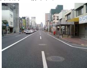
緊急輸送路下の管きょの耐震化
