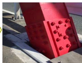
緊急対策を実施（添接板補強）
