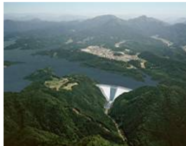
設楽ダム建設地
