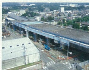
伊豆縦貫自動車道 長泉高架橋 （静岡県駿東郡）
