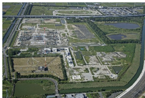
建設が進む日光川下流浄化センター (H19.9 撮影)
