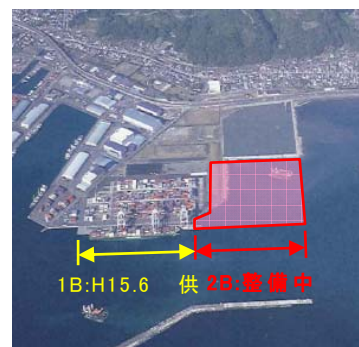
清水港 新興津地区国際海上コンテナターミナル
