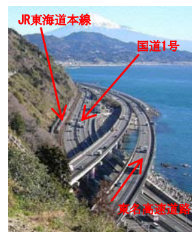
地すべりと併走する重要交通施設
