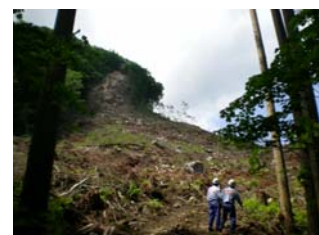
土砂災害危険箇所調査 (岩手・宮城内陸地震、平成20年6月)
