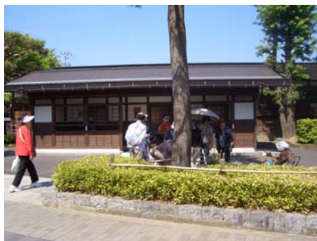
陣屋前の高機能トイレ
