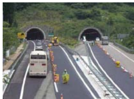
東海北陸道の4車線化工事の様子
