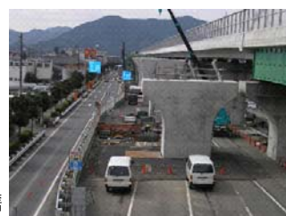
＜昭府地区橋梁工事の状況＞
