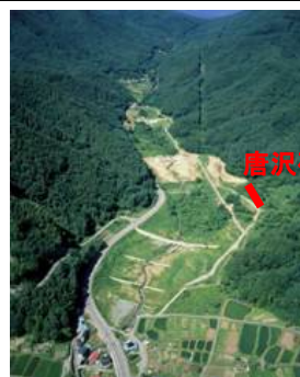
唐沢砂防えん堤 施工箇所
