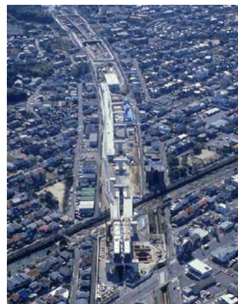
＜有松地区の工事状況＞
