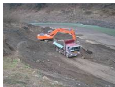
■掘削状況写真
