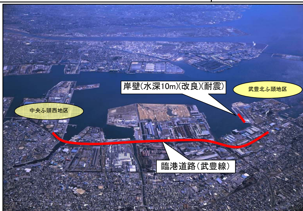
■衣浦港中央ふ頭西・武豊北ふ頭地区 大規模地震対策の促進
