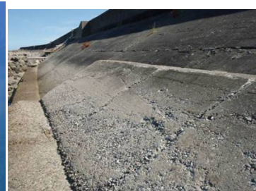
堤防表護岸の状況 (浜田工区)
