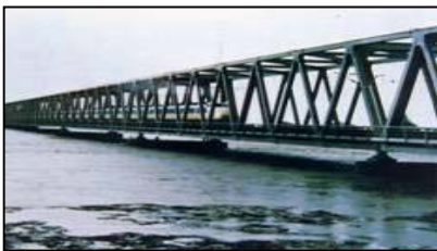
◇昭和50年8月 台風6号による出水状況
