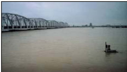
◇平成14年7月 台風6号による出水状況
