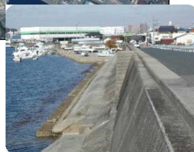
老朽化の著しい護岸
