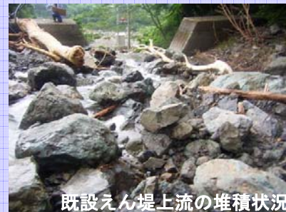
既設えん堤上流の堆積状況
