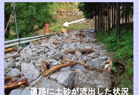
道路に土砂が流出した状況
