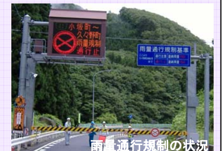
雨量通行規制の状況
