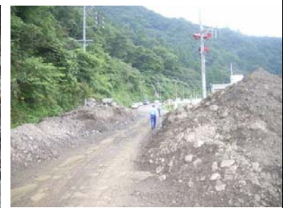
国道417号への流出状況
