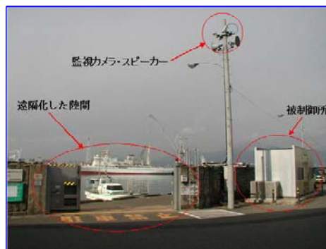
■清水港海岸の津波・高潮防災ステーション（操作局および陸閘） （静岡市清水区）
