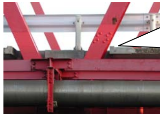
補修後の状況(H19.7.28上り線補強完了)
