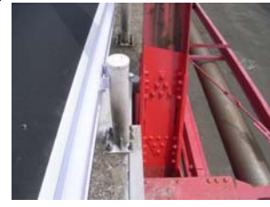
添設材による補強の状況
