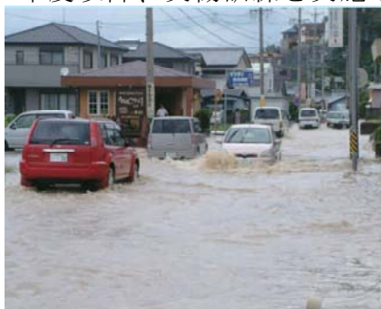
■平成 16 年 9 月台風 21 号による宮川の被害状況（伊勢市辻久留）
