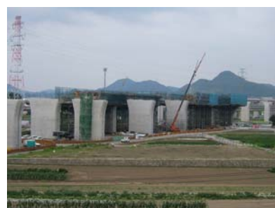
東海環状道自動車道
