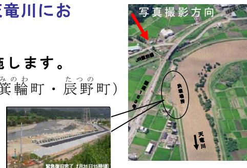
天竜川右岸堤防の決壊（H18.7）
