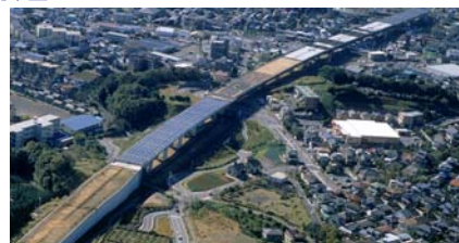
伊豆縦貫自動車道
