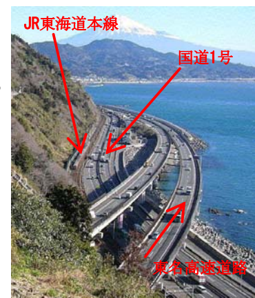
地すべりと併走する 重要交通施設
