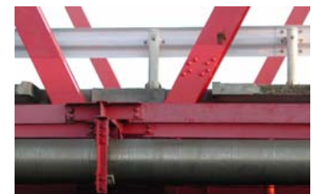
補修後の状況 (H19.7.28 上り線補強完了)
