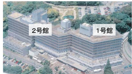
県西部浜松医療センター1・2号館
