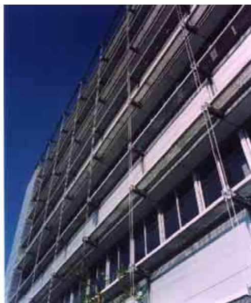
直射日光をさえぎる庇
