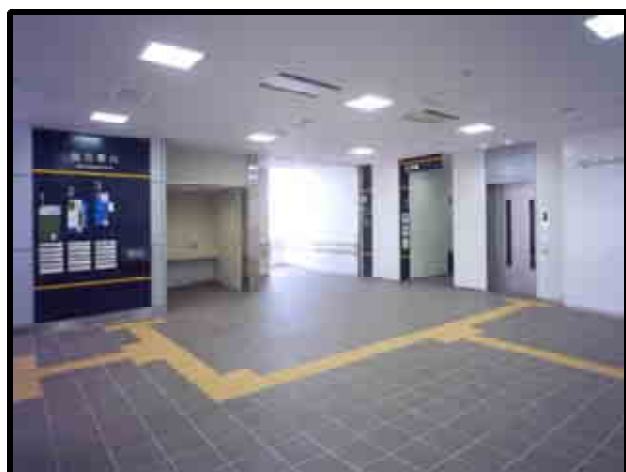
玄関ホールの誘導タイル整備例
