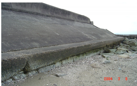
堤防老朽化状況（川尻工区）
