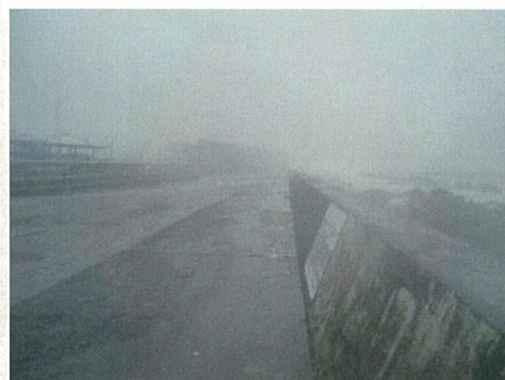
【台風による越波状況】
