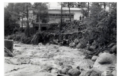
昭和39年出水による被害状況 （現在のこまくさの湯付近）
