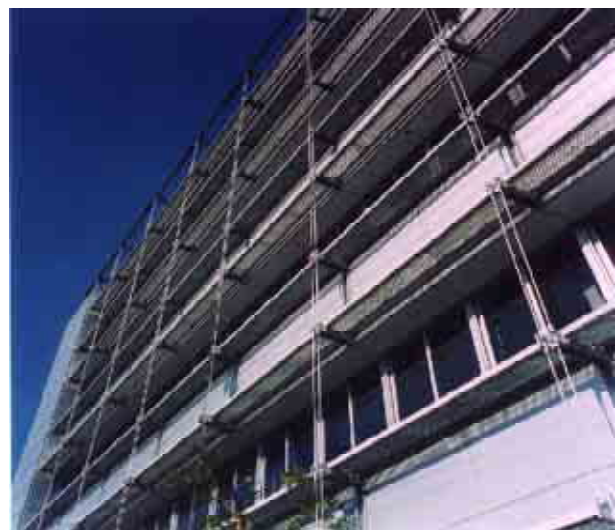
日射をさえぎる庇の整備例
