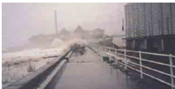
H17 7月駿河海岸焼津工区 越波状況
