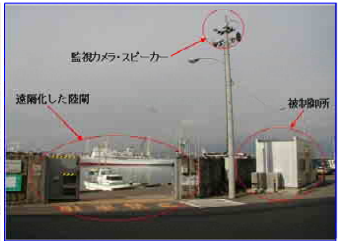
清水港海岸の津波・高潮防災ステーション（操作局および陸閘）
