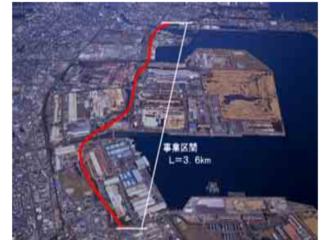
衣浦港 臨港道路の4車線化
