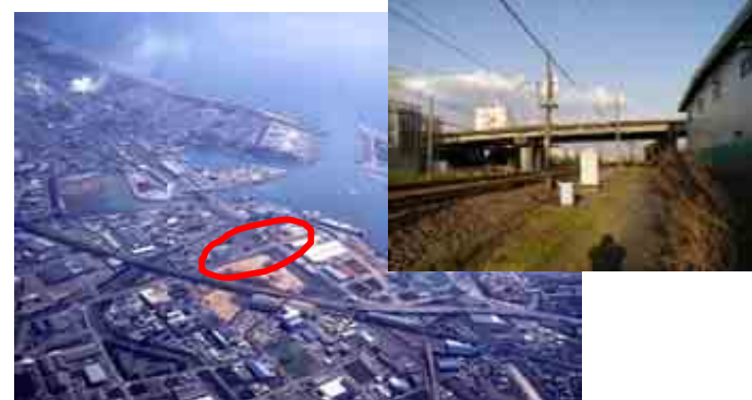
田子の浦港 道路(改良)
