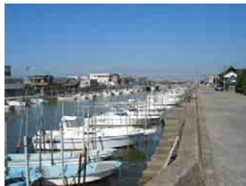
護岸等へ不法係留される放置艇（吉田港）
