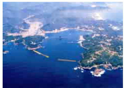
下田港 下田地区 避難港防波堤
