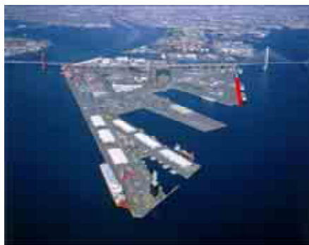
名古屋港金城ふ頭地区 岸壁改良
