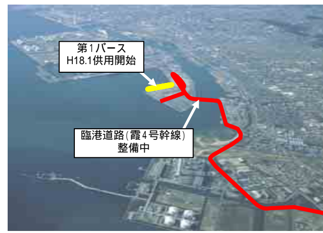
四日市港 国際海上コンテナターミナル及び臨港道路
