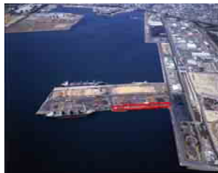
衣浦港 中央ふ頭西地区 岸壁(-10m)(耐震改良)
