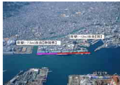
清水港日の出地区 岸壁改良
