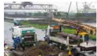
回収した流木等の陸揚げ
