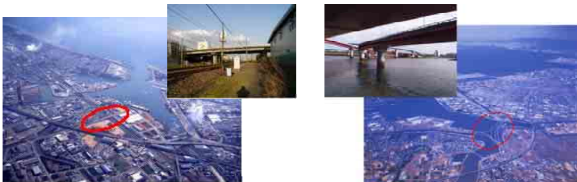
田子の浦港 中央地区 道路（改良）
