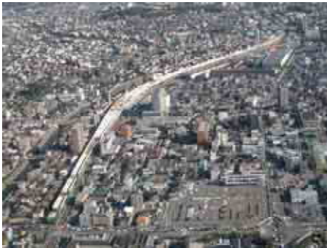
名鉄名古屋本線(天白川～左京山)連続立体交差事業(鳴海駅付近)
