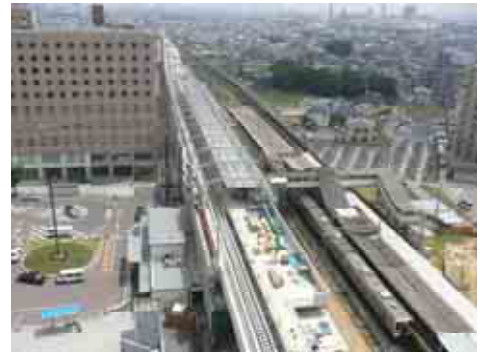
JR東海中央本線連続立体交差事業(勝川駅付近)
