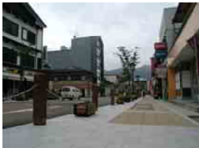
電線が地中化された街並み(古川地区)
