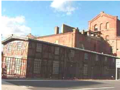
赤レンガ建造物の修景 （蔵のまち周辺地区）
