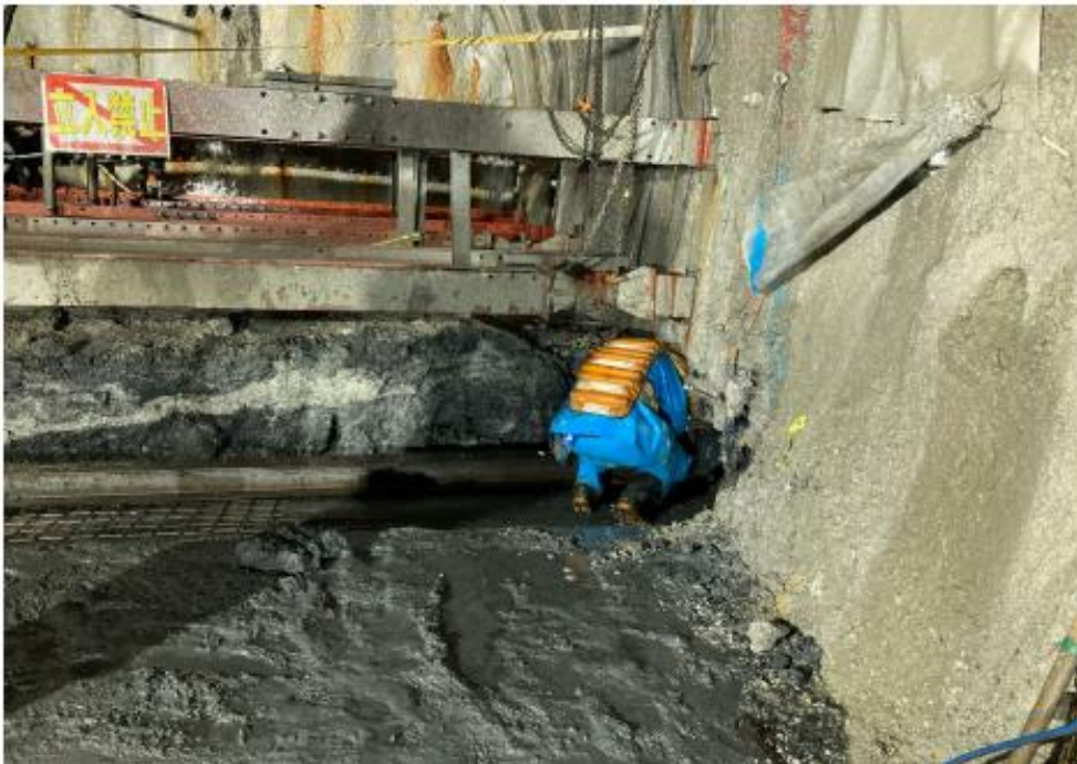
高い土圧に耐えるために切ばり(横方向の鋼材)を設置
