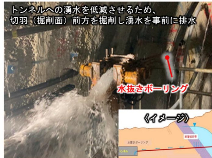
＜水抜きボーリング＞
