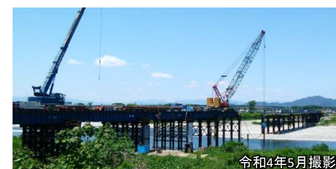
＜左岸側＞仮橋の施工状況
