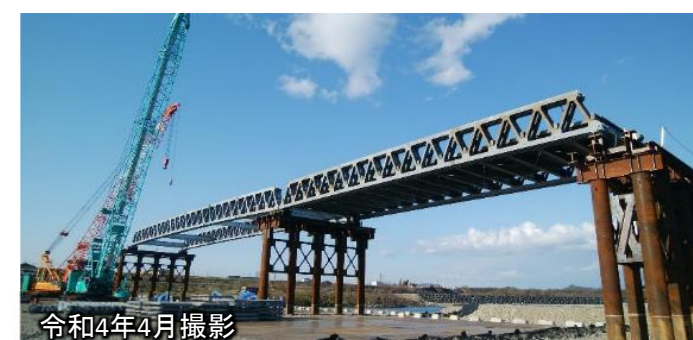
＜右岸側＞応急組立橋の施工状況
