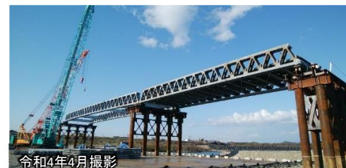
＜右岸側＞応急組立橋の施工状況
