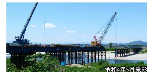
＜左岸側＞仮橋の施工状況
