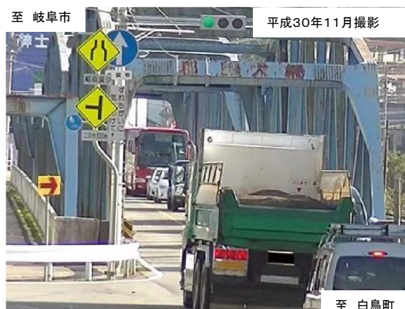
写真2 対向大型車の通過待ち状況
