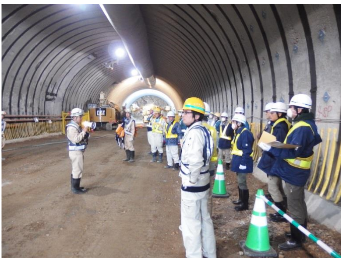
トンネル坑内視察状況
