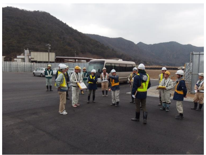
仮置きヤード視察状況
