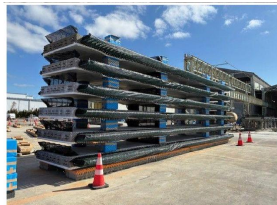
工場製作 PO床版
