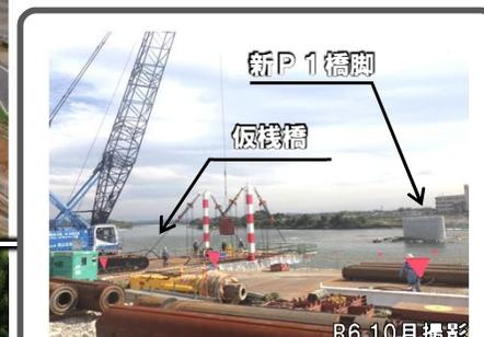
バント（橋を架けるための仮支え）設置に使用する工事用仮栈橋の設置作業を行っています。
