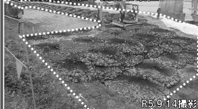
旧A1橋台撤去・新A1橋台を造るため仮締切りを設置しています。
