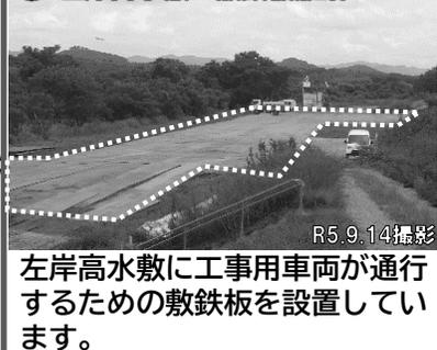
左岸高水敷に工事用車両が通行するための敷鉄板を設置しています。
